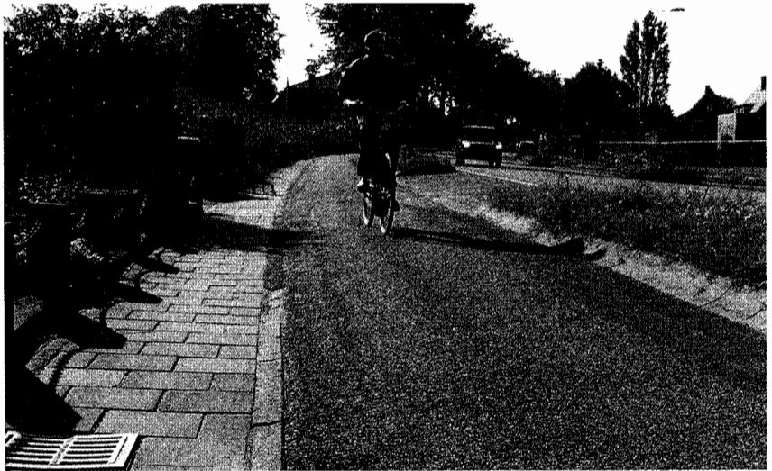
Rafeling asfaltbeton.
