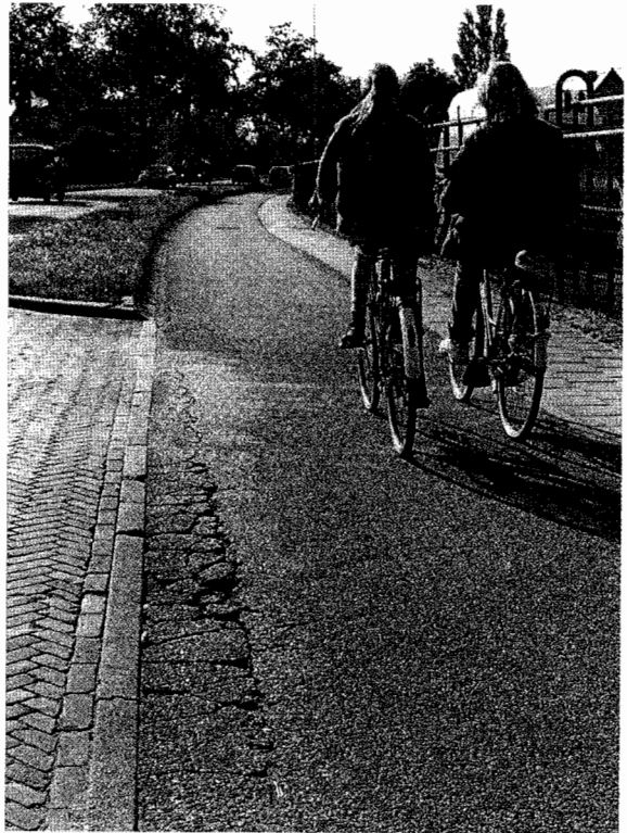
Craquelé asfaltbeton.
