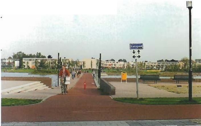
Fietspad van rood gekleurd asfaltbeton.
