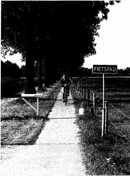
Fietspad van cementbeton.
